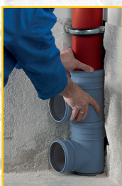
4. wepchnąć gałąź przesuwną do gniazda rozgałęzienia wtykowego
