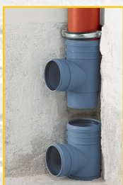
3. włożyć odgałęzienie wtykowe do dolnej rury.
