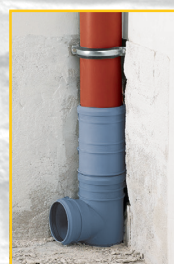
4. wcisnąć tuleję przesuwną do gniazda gniazdo rozgałęzienia wtykowego
