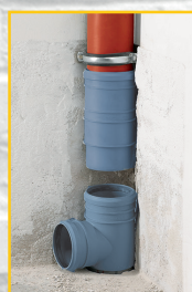
3. włożyć odgałęzienie wtykowe do dolnej rury.
