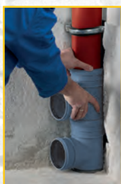
4. duw de schuiftak in de mof van de insteektak.
