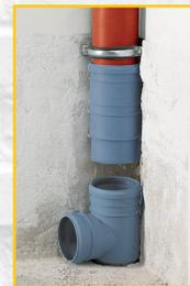
3. inserire il ramo a innesto nel tubo inferiore
