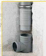
3. inserire il ramo a innesto nel tubo inferiore
