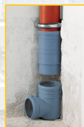
3. A leágazót az alsó csőrészbe helyezzük.
