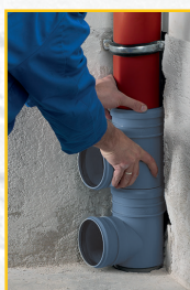
4. Végül csatlakoztatjuk a két ágat.
