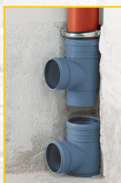
3. Az alsó "T" idomot az alsó csőrészbe helyezzük.
