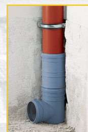
4. A két csatlakozót összerakjuk.
