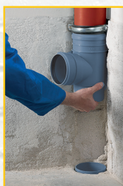
2. A hosszútokot a felső csőrészbe toljuk.
