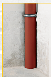
1. A HT csövet a talajtól 33 cm-es magasságban kivágjuk.
