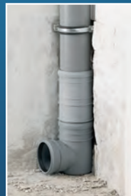
4. Schiebemuffe in den Steckabzweig schieben
