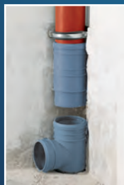
3. Steckabzweig in un- teres Rohr stecken
