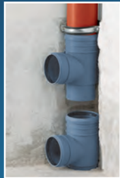
3. Steckabzweig in un- teres Rohr stecken
