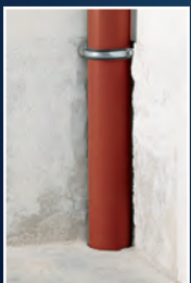
1. Bestehende Leitung 33 cm ausschneiden
