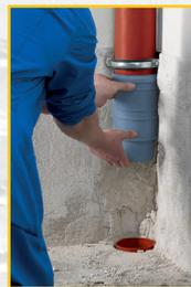
2. Schiebemuffe über oberes Rohr schieben
