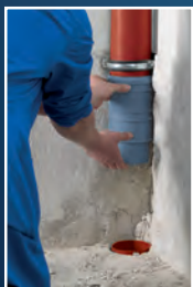
2. Schiebemuffe über oberes Rohr schieben
