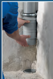
2. Schiebemuffe über oberes Rohr schieben
