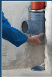
2. Schiebeabzweig über oberes Rohr schieben
