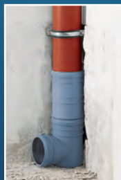
4. Schiebemuffe in den Steckabzweig schieben
