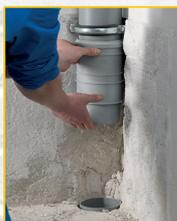
2. Schiebemuffe über oberes Rohr schieben
