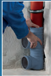
4. Schiebeabzweig in die Muffe des Steckab- zweigs schieben
