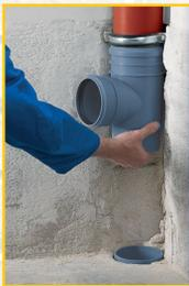
2. Schiebeabzweig über oberes Rohr schieben
