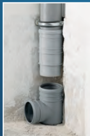
3. Steckabzweig in unteres Rohr stecken
