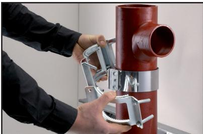
1. Beide Schellenhälften müssen die Rohrenden gleichmäßig umschließen.
