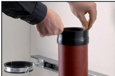
1. Helyezze a hüvelyt a cső végére. A tömítés középső távtartó gyűrűje a csövön nyugszik.
