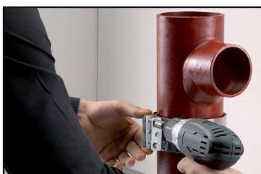
6. Placez le connecteur et serrez-le uniformément des deux côtés à l'aide d'un tournevis.
