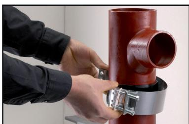
5. Fixez la bande métallique et fixez-la avec des vis.
