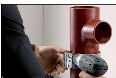
6. Posizionare il connettore e stringerlo uniformemente su entrambi i lati con un cacciavite.
