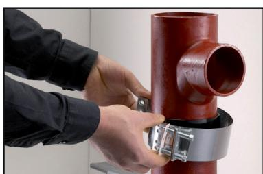
5. Připevnění kovového pásu a fixace pomocí šroubů.
