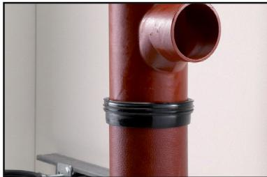
3. Helyezze fel a kívánt csatlakozó darabot vagy csövet.
