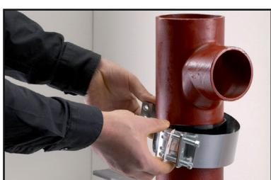
5. Attaccare la banda metallica e fissarla con delle viti.
