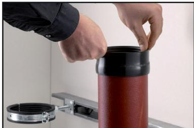
1. Plaats de mof op het uiteinde van de pijp. De middelste afstandsring van de afdichting rust op de pijp.
