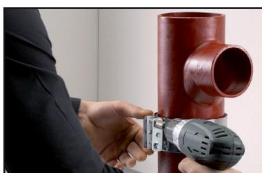
6. Coloque el conector y apriételo uniformemente en ambos lados con un destornillador.
