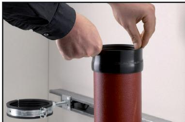
1. Coloque el manguito en el extremo de la tubería. El anillo espaciador central de la junta se apoya en el tubo.
