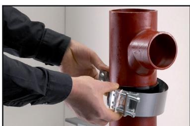
5. Bevestig de metalen band en zet hem vast met schroeven.
