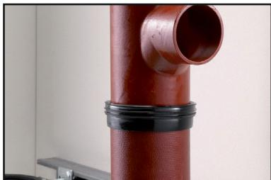
3. Nasadte požadovaný spojovací kus nebo trubku.
