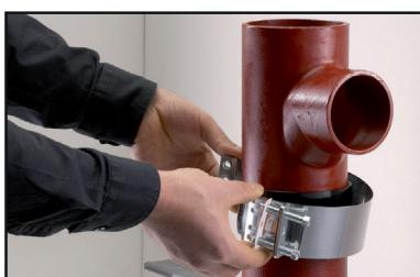
5. Coloca la banda metálica y fíjala con tornillos.
