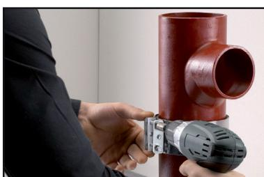
6. Plaats de connector en draai hem aan beide zijden gelijkmatig vast met een schroevendraaier.
