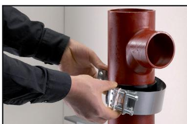
5. Pripojenie kovového pásu a fixácia
