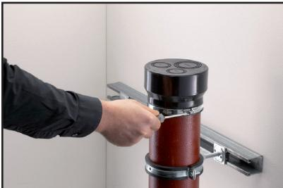
1. Das offene Ende der OHA-Multi-Anschlussmuffe über das Rohrende schieben und die Schlauchklemme in der dafür vorgesehenen Vertiefung positionieren. Anschließend die Schlauchklemme, unter Einhaltung ihrer Position, fest anziehen.
