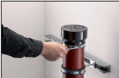
1. Far scorrere l'estremità aperta del manicotto di collegamento multiplo OHA sull'estremità del tubo e posizionare la fascetta stringitubo nell'apposita rientranza. Poi stringere saldamente la fascetta stringi tubo mantenendo la sua posizione.
