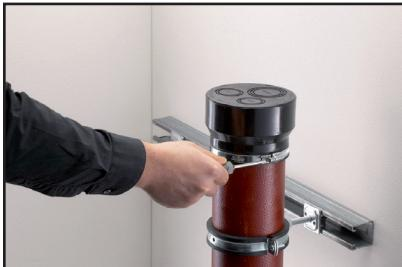
1. Deslice el extremo abierto del manguito de conexión múltiple OHA sobre el extremo de la tubería y coloque la abrazadera de la manguera en el hueco previsto. A continuación, apriete firmemente la abrazadera de la manguera manteniendo su posición.
