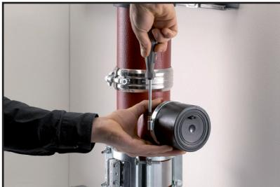
1. Das offene Ende der OHA-Anschlussmuffe bis zum Anschlag auf das SML-Rohr schieben, dann mit der Schlauchklemme am Rohr befestigen.
