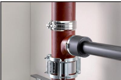
3. Segnare il tubo di collegamento alla profondità di installazione richiesta, applicare il lubrificante e spingere dentro.
