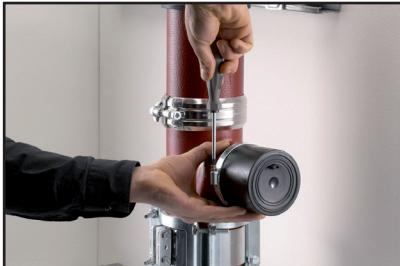
1. Poussez l'extrémité ouverte du manchon de raccordement OHA sur le tuyau SML jusqu'à la butée, puis fixez-le au tuyau à l'aide du collier de serrage.
