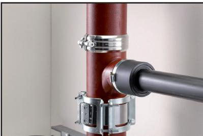
3. Anschlussrohr auf die notwendige Einbautiefe markieren, mit Gleitmittel versehen und einschieben.
