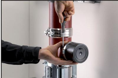
1. Nasuń otwarty koniec tulei połączeniowej OHA na rurę SML do oporu, a następnie przymocuj ją do rury za pomocą opaski zaciskowej.
