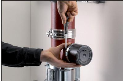
1. Empuje el extremo abierto del manguito de conexión OHA en la tubería SML hasta el tope y fíjelo a la tubería con la abrazadera.
