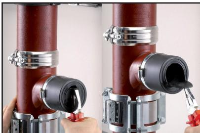
2. Opatrně pomocí kleští vytáhněte a odstraňte gumovou membránu na otevíracím kolíku.
